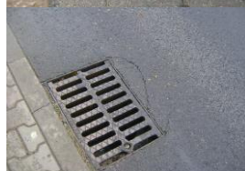
uszkodzona/spękania krawędź
