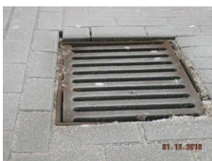
zaniżenie lub zawyżenie względem nawierzchni o 0,5 cm do regulacji
